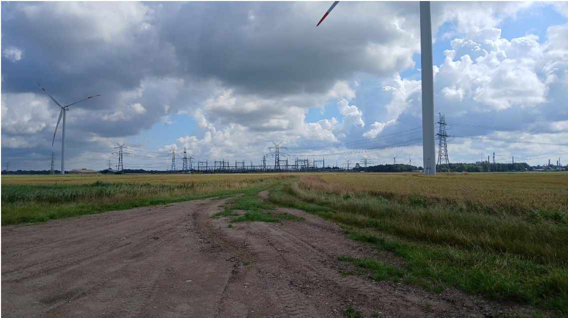
Abbildung 23: Blick in Richtung des Umspannwerks bei Lieth
