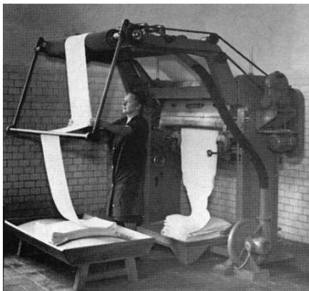
Links ein Gerät, welches dort bei der Firma **Wulf und Sohn** eingesetzt wurde: das **Kalander**
