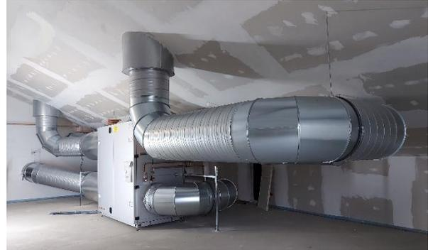
Auf dem Dachboden (ca. 100m<sup>2</sup>) im Nordtrakt wird ebenfalls fleißig gewerkelt. Das „riesige“ Lüftungsgerät (siehe Foto) für die Strang- und Raumentlüftungen der Säle ist bereits an seiner Endposition aufgestellt und die notwendigen Rohre und Schalldämpfer sind angebaut und ausgerichtet.
