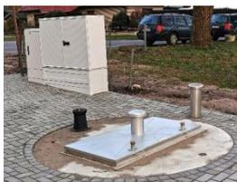
Anwohner fühlten sich durch Geräuschemissionen (vor allem im Bereich tiefer Töne!) des Abwasserzweckverbandsschachtes erheblich gestört. Als Maßnahme wurden u.a. zunächst auf die Lüftungsrohre (links) höhere und dickere Schalldämpfer(?) aufgesetzt. Inzwischen wurden diese noch mit Bandeisen zur Minimierung von Schwingungen stabilisiert. Was kommt wohl jetzt noch? Wie sieht es aus mit Hygiene bzw. mit Infektionsschutz?
