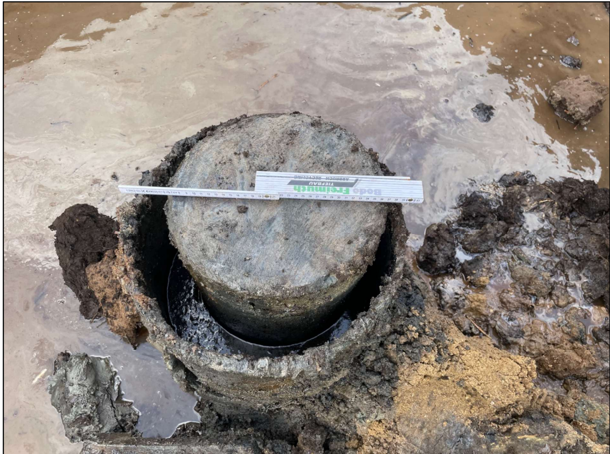
Abbildung 6: Aufgrabung der Bohrung Holstein 23 am 17.09.2025 mit zwei Rohrtouren
