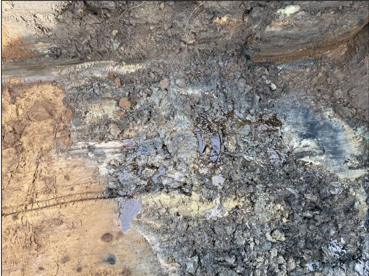
Abbildung 5: Aufgrabung der Bohrung Holstein 10 am 17.09.2025 mit verunreinigtem Boden in der Baugrube
