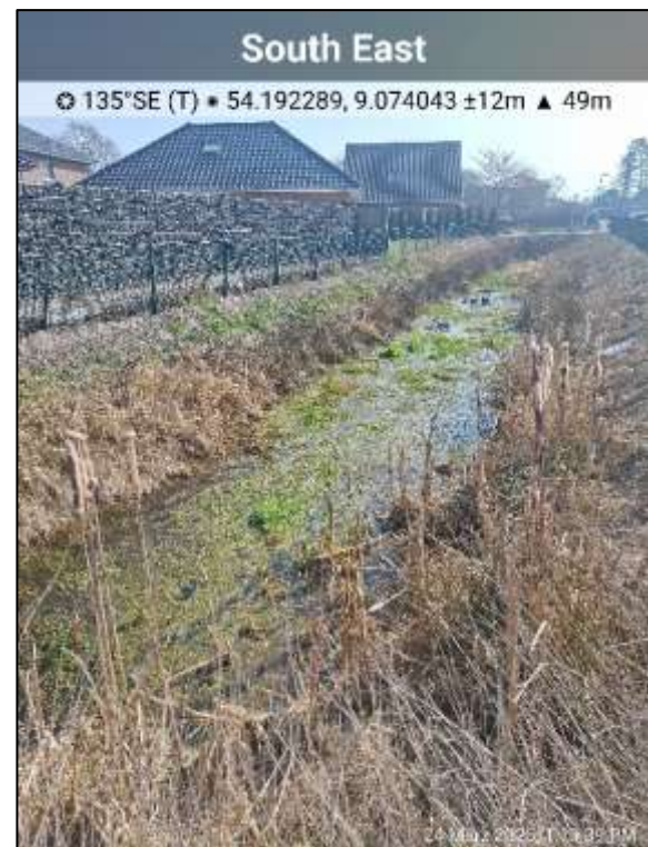
Abbildung 11: mittleres der drei RRB östlich des Vorhabengebietes, Gewässer Nr. 9 (Planungsbüro ALSE 24.03.2025)
