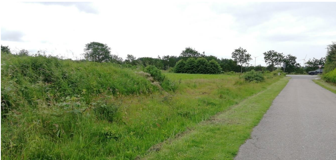
Abb. 2.8 Blick auf die Zufahrt im nordwestlichen Teil des Knicks.
