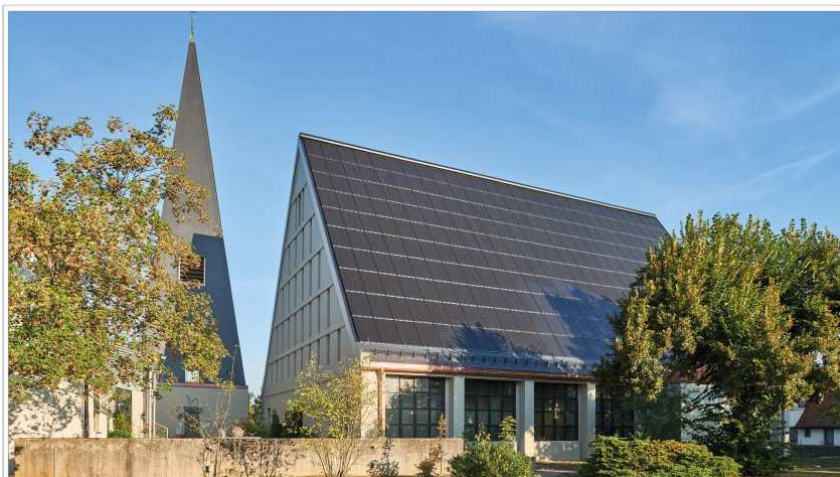
Solardach einer Kirche in Mittelfranken
